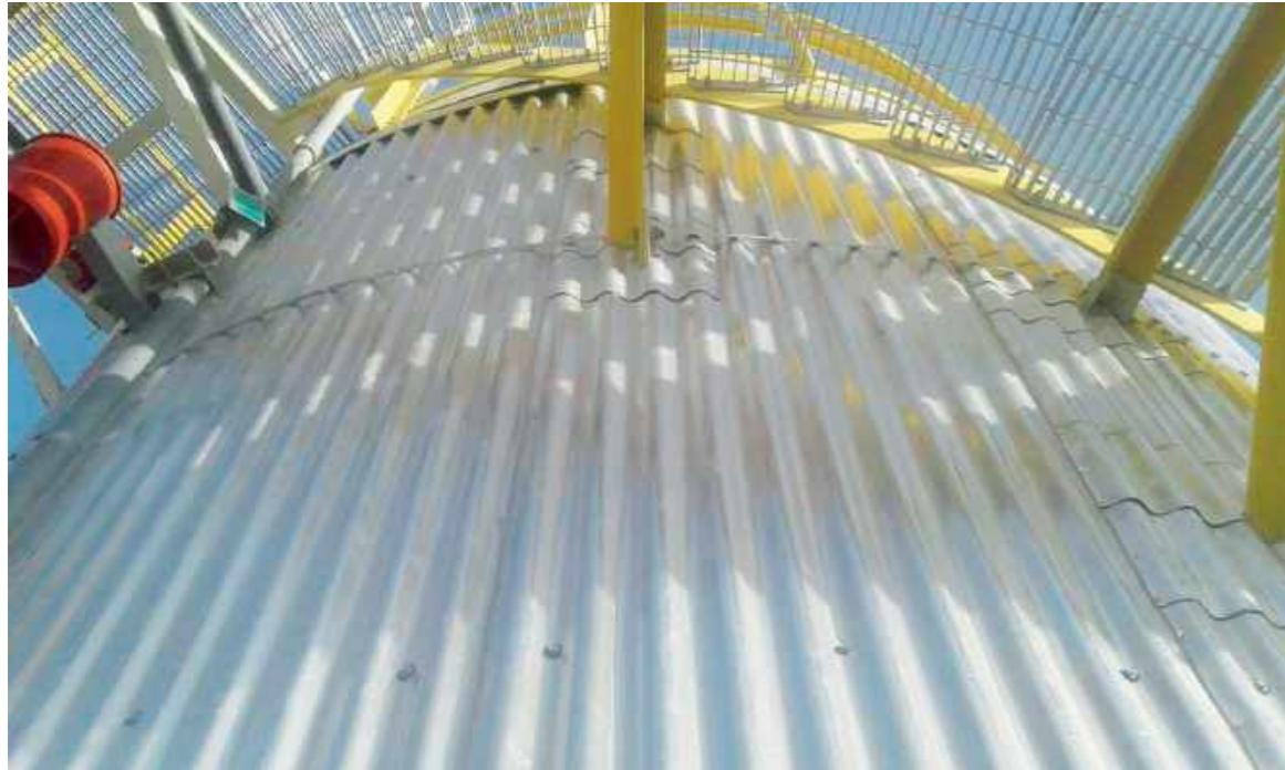
Projet: rectification du bardage de la cage de l'ascenseur pour une meilleure étanchéité - centrale à cycle combiné Steg Sousse
